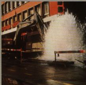
Reparation av körbrott
