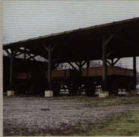
Drag- och rangeringsarbeten
